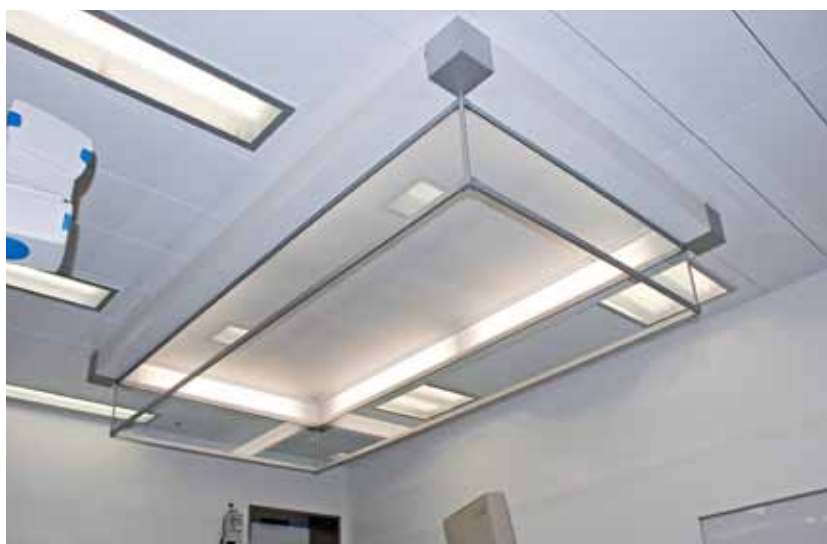
CH-Yverdon-les-Bains, eHnv – Hôpital Yverdon-les-Bains
